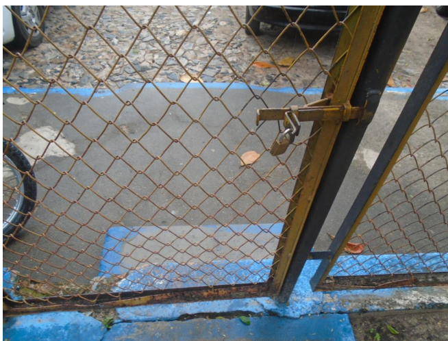
Imagem 02 – Foto tirada in loco dos degraus da escada na entrada da escola. Fonte: COPROJ-SEINF.
