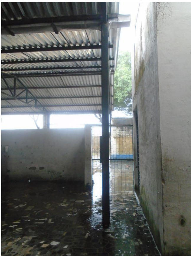
Imagem 25 – Imagem da cobertura metálica atual. Fonte: COPROJ-SEINF.
