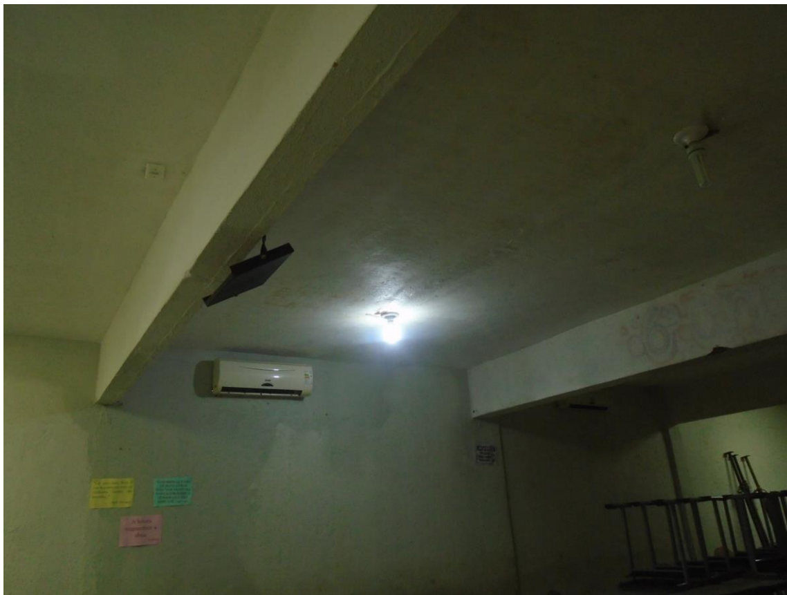
Imagem 14 – Foto tirada in loco da laje e parede do auditório no térreo. Fonte: COPROJ-SEINF.
