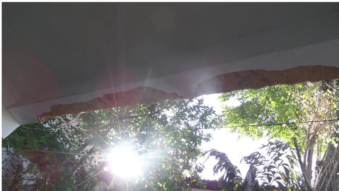
Imagem 07 – Foto tirada in loco da viga do primeiro andar. Fonte: COPROJ-SEINF.
