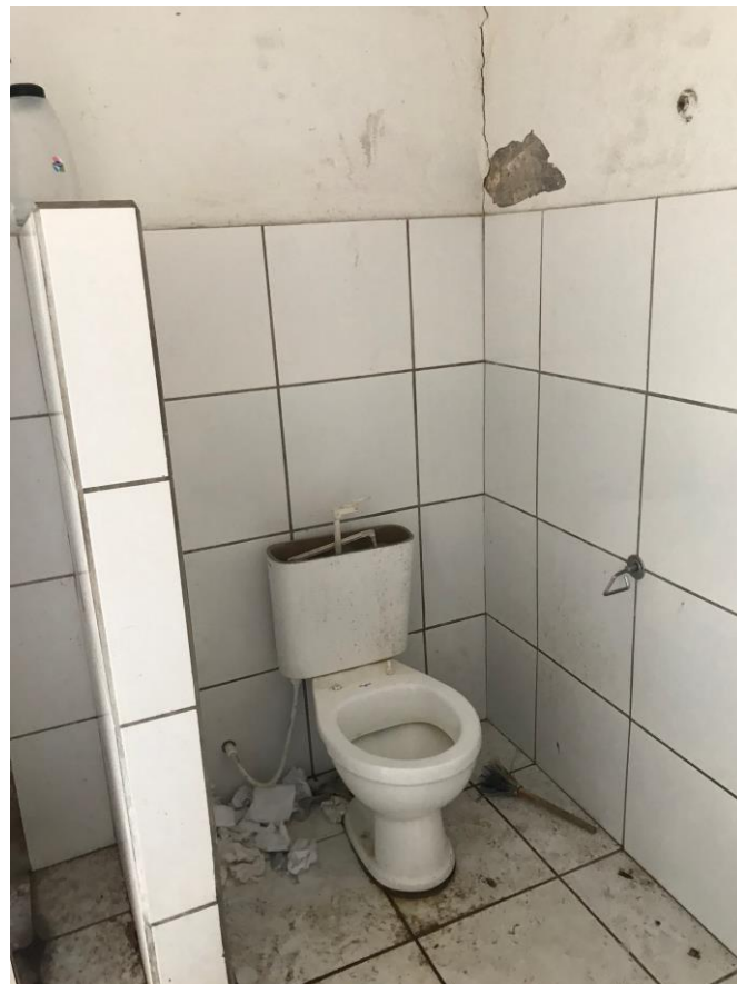
Imagem 16 – Foto tirada in loco em um dos banheiros. Fonte: COPROJ-SEINF.
