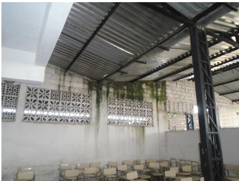
Imagem 10 – Foto tirada in loco da cobertura metálica. Fonte: COPROJ-SEINF.
