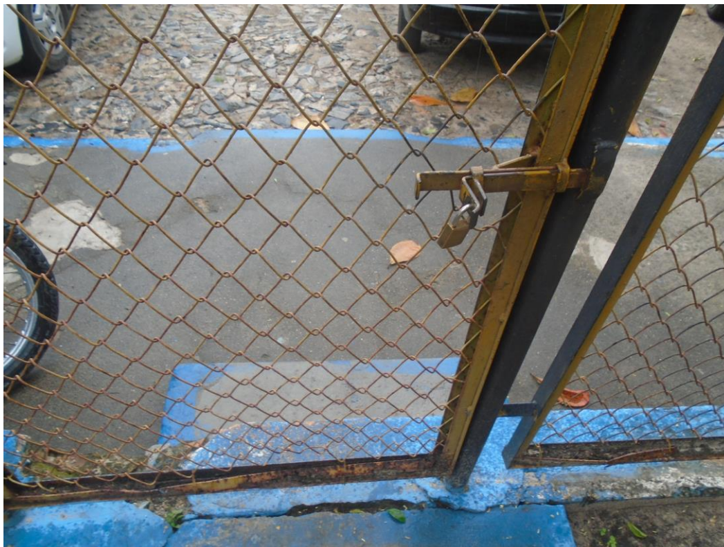
Imagem 18 – Foto tirada in loco do portão/gradil de ferro na entrada. Fonte: COPROJ-SEINF.
