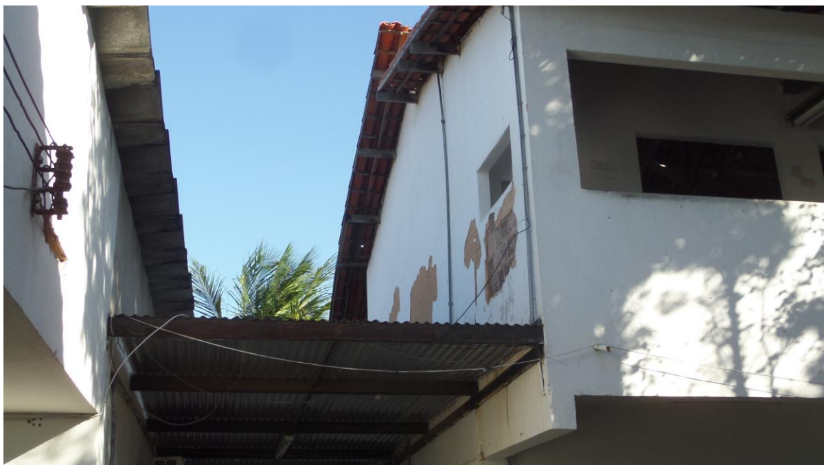
Imagem 08 – Foto tirada in loco da alvenaria externa. Fonte: COPROJ-SEINF.
