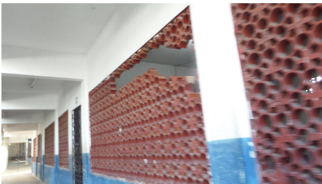
Imagem 20 – Foto tirada in loco dos cobogós das salas de aula. Fonte: COPROJ-SEINF.
