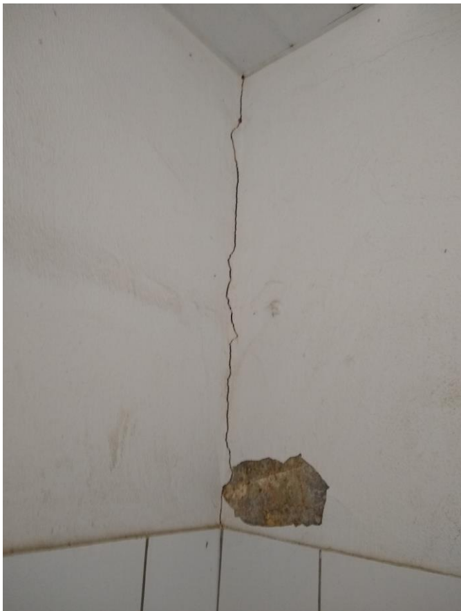
Imagem 15 – Foto tirada in loco em um dos banheiros. Fonte: COPROJ-SEINF.
