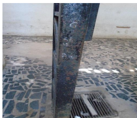
Figura 3 e 4 - Estruturas metálicas fragilizadas pelo efeito da corrosão.
