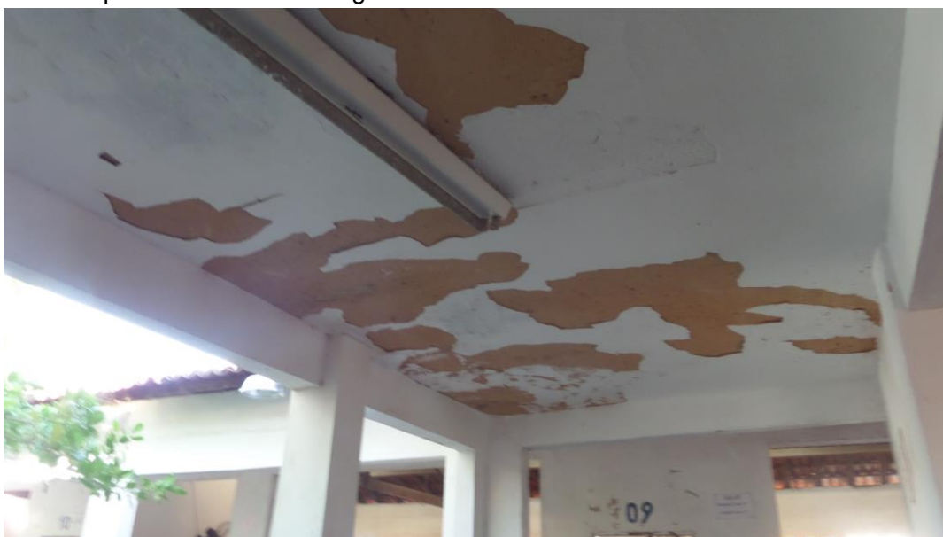
Imagem 06 – Foto tirada in loco da laje do primeiro andar. Fonte: COPROJ-SEINF.
